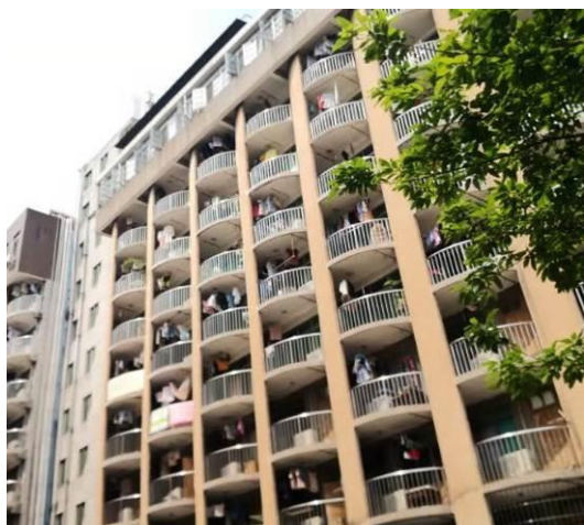
三元里校区学生宿舍 5 栋栏杆更换
