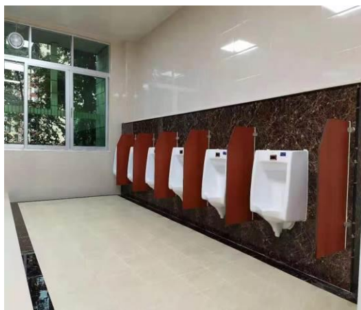
三元里校区办公楼北侧卫生间改造项目
